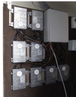
8 Modulwechselrichter
