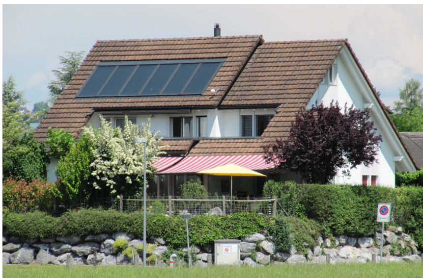
Abbildung 3: Einfamilienhaus mit 15 m 2 Solarwärme-Anlage.
